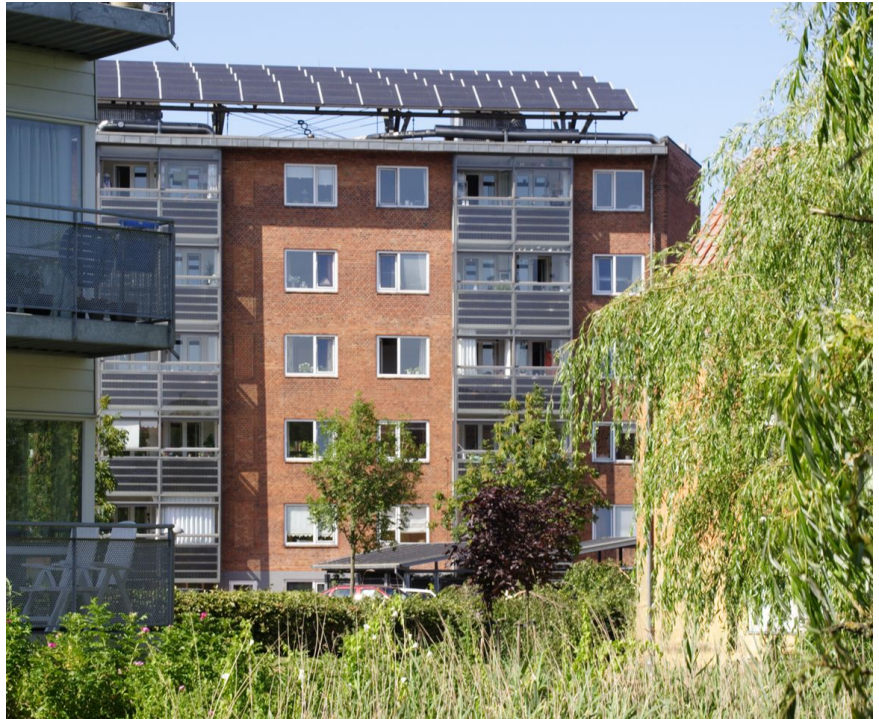
Solceller skulpturelt placeret på tag og integreret i altanbrystninger (Foto Rob Marsh, SBI)
