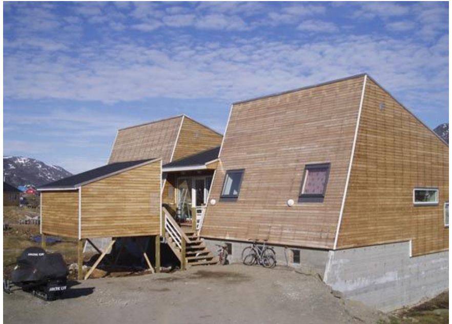
Lavenergihuset Sisimiut, Grønland
